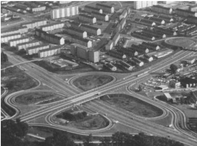
Autogerechter Städtebau in Braunschweig in den 1960er Jahren. So hätte um ein Haar auch die Ständlerstraße in Neuperlach ausgesehen. Das dortige Autobahnkreuz wurde allerdings nie gebaut; die eigenartige Verschwenkung der Abfahrt von der Ständlerstraße ins Wohngebiet um das imaginäre Autobahnkleblatt herum zeigt jedoch noch heute, was damals angesagt war. Diese Münchner Stadtbrache lässt sich für eine Nachverdichtung Neuperlachs gut nutzen. Bild: braunschweiger forum
